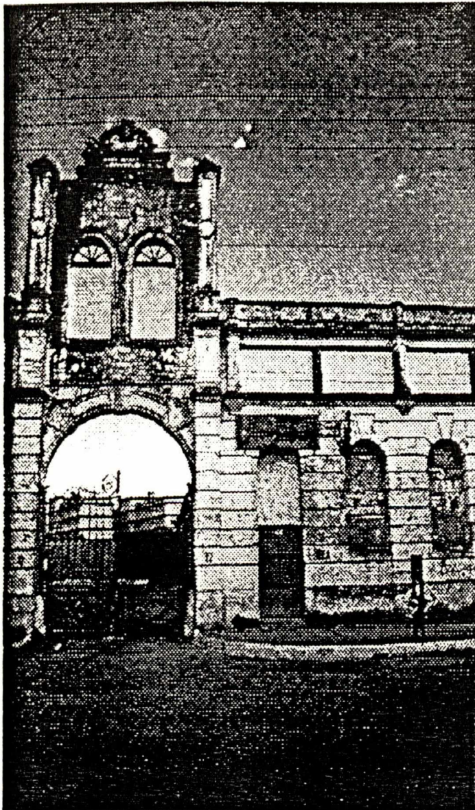
O projeto preserva o patrimônio arquitetônico e integra as áreas aterradas.
