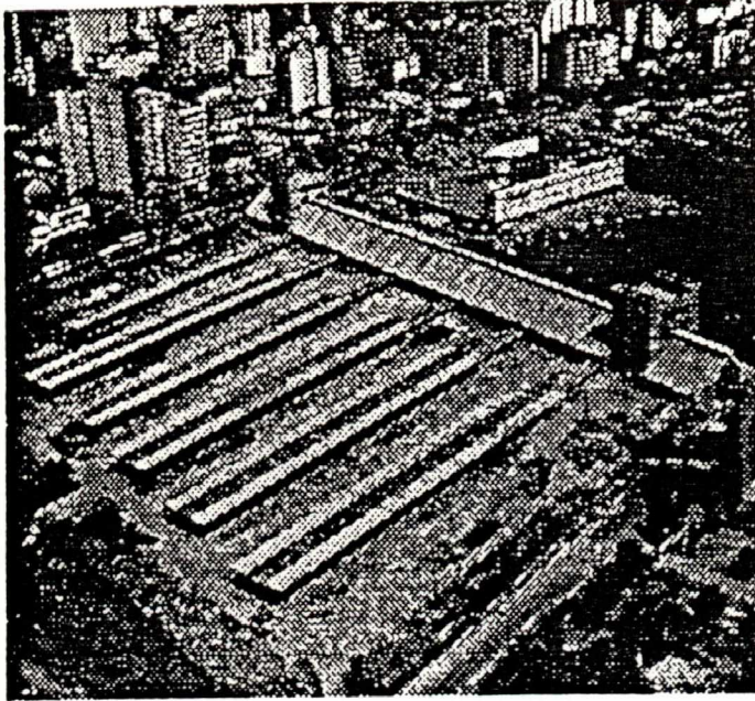
As obras do novo terminal rodoviário de Niterói.
